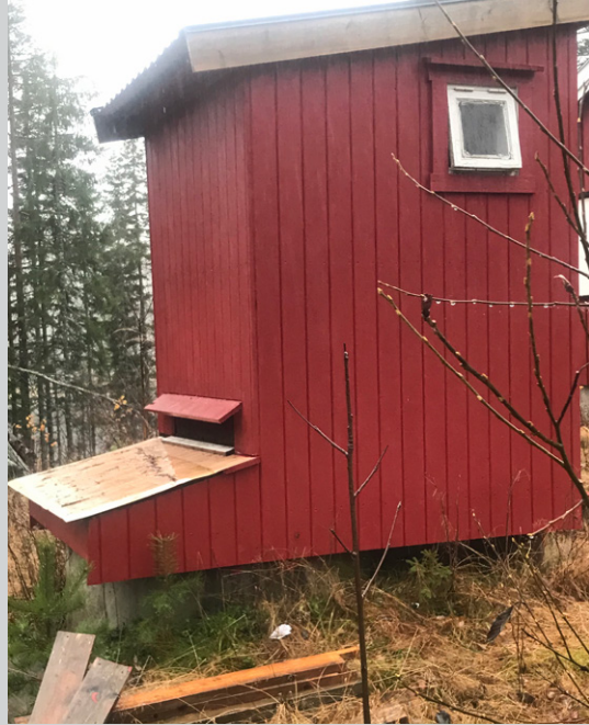
Fra sida kommer stjerten tydelig fram. Den har en skrålem over halvparten av røret som gjør det lett å få dritten ut.
